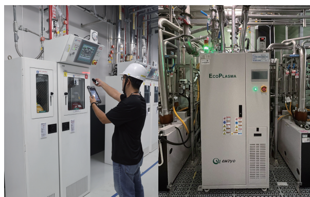
汰換與新設含氟溫室氣體現址式處理設備
