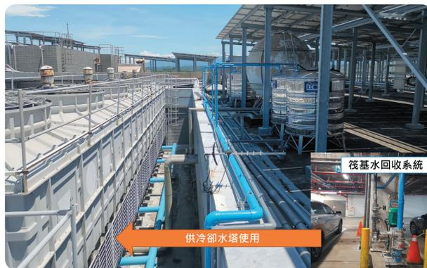
竹南廠筏基水回收系統供冷卻水塔使用
